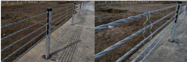
写真-19 防護柵（左：中間支柱、右連結材）
