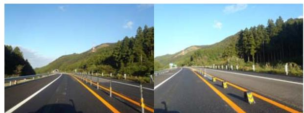
写真-7 磐越道に試行導入されたワイヤロープ式防護柵
