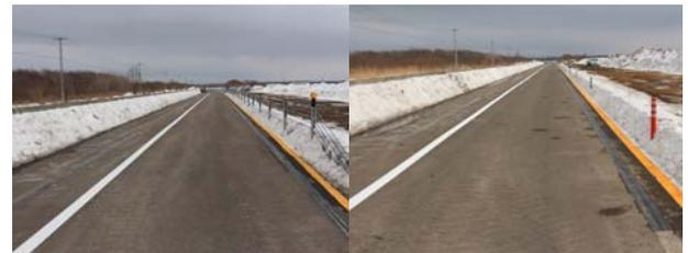
写真-5 走行試験区間の状況(左:ワイヤロープ式防護柵, 右:ラバーポール)
