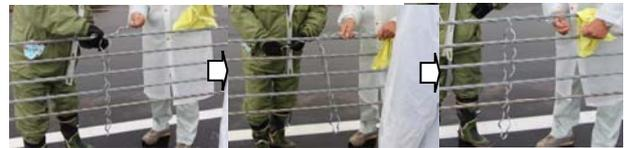
写真-12 ロープ連結材の取り付け
