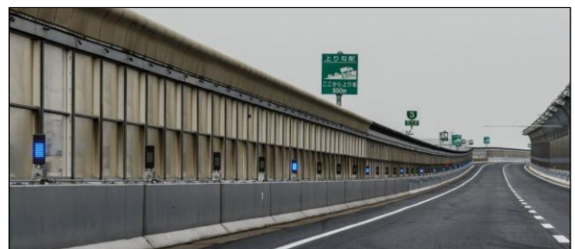
図-1 速度回復誘導灯（阪神高速3号神戸線上り 深江サグ部）
