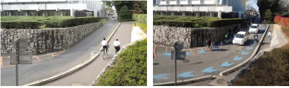
写真-2 整備前後での区間 II 北から南方面を撮影 (左: 整備前 右: 整備後)
