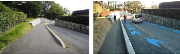
写真-3 整備前後での区間 II 南から北方面を撮影 (左: 整備前 右: 整備後)
