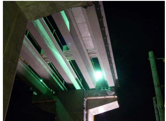
写真3 PCU桁架設状況
