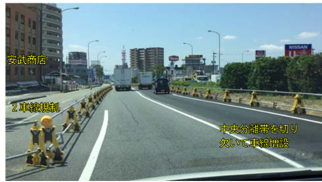
図-28 中央分離帯を切り欠いて車線を確保した事例
