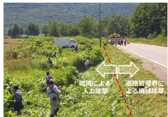
写真-4 官民協働による除草（一斉除草：7月）
