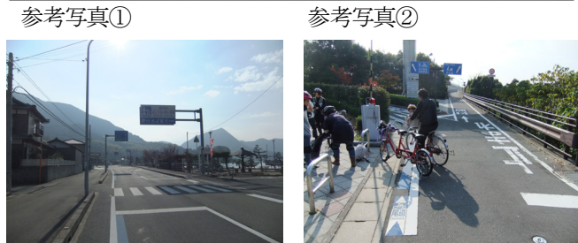
※参考写真は、急減速発生メッシュ内の地点を撮影したものであり、 実際の発生箇所の特定に関しては、現地調査等が必要。
