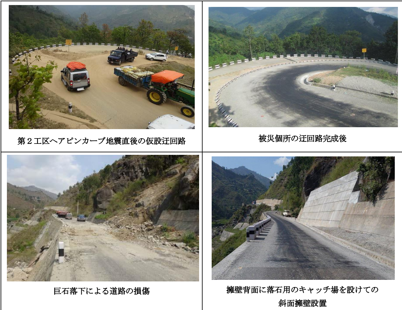
図 17 ネパール大地震に対する応急復旧の実施箇所
