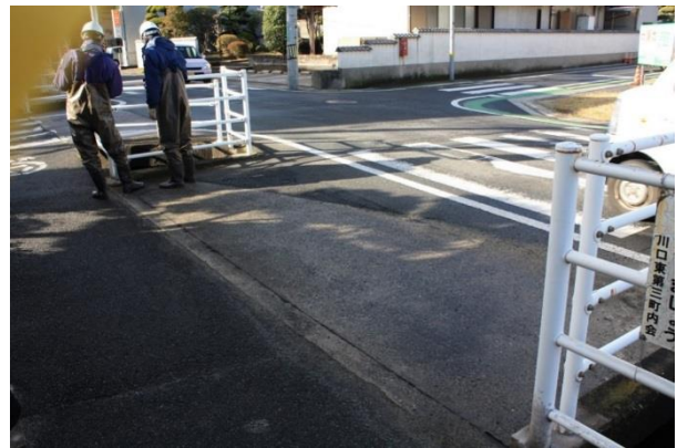
写真-2 幅員が広く下部に入れない橋梁
