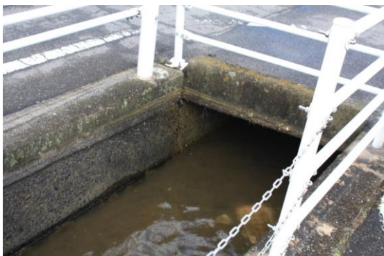
写真-1 幅1m程度の小規模な水路と橋梁
