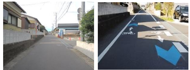
写真-3 整備前後での区間① (左:前 右:後)
