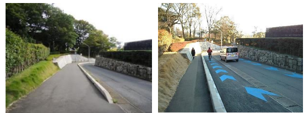
写真-4 整備前後での区間② カーブ (左:前 右:後)
