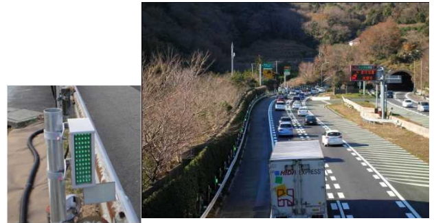
図3 発光体の点灯状況（明かり部）
