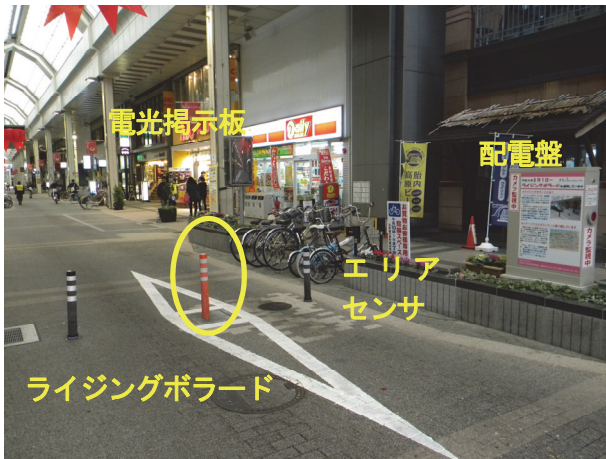
図-1 新潟市の商店街で導入されたソフトライジングボラードシステム
