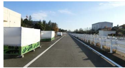
図-2 パーテーション設置の様子
