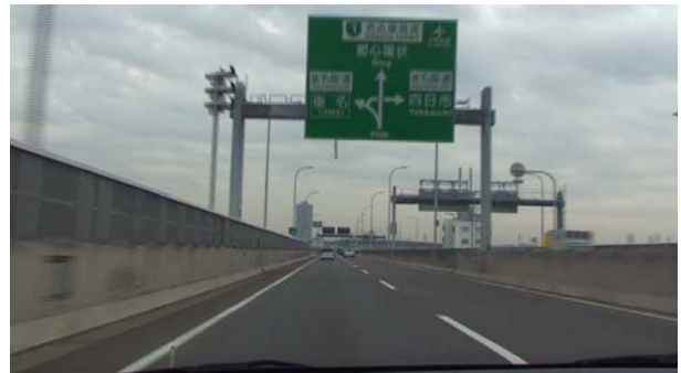
写真-2 図形タイプ標識 (600m 手前)
