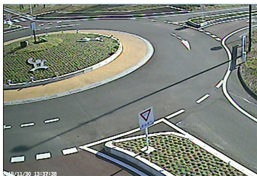
写真-2 調査時の状況【立田町ラウンドアバウト】
