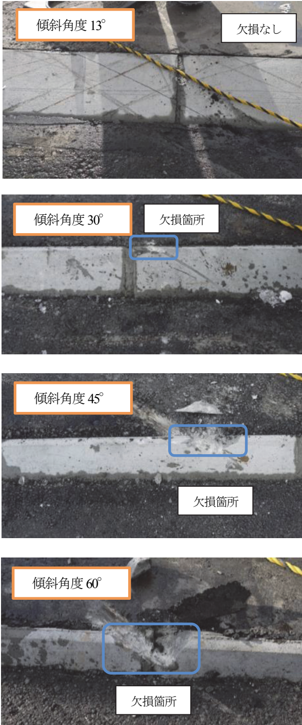
写真-9 縁石の損傷状況（ホイールローダ）
