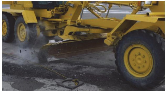
写真-8 ブレードの接触状況 (傾斜角度30° , モータグレーダ)
