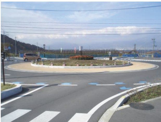
写真-1 ラウンドアバウト(長野県須坂市)
