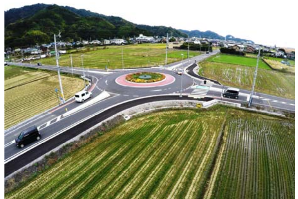
写真-1 完成した山の手環状交差点
