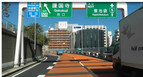
図-2 注意喚起カラー舗装の例 (首都高速5号池袋線下り護国寺カーブ)
