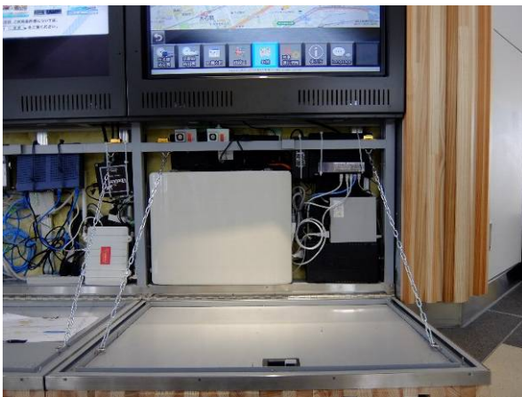
図7 摩耶駅でのセンサーの筐体内への設置
