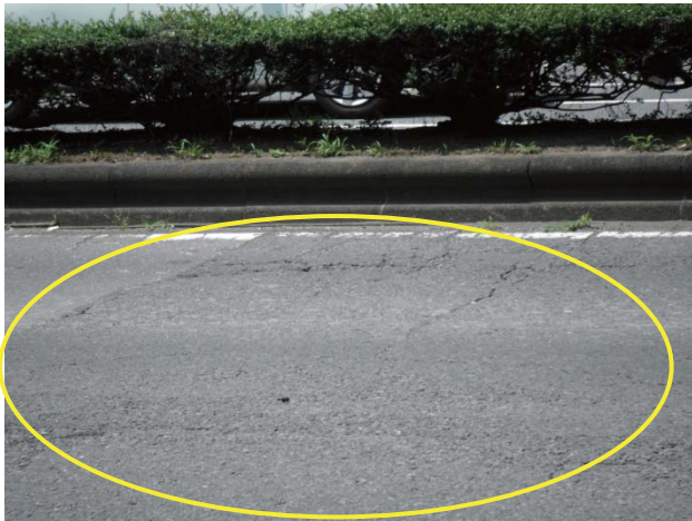
図-13 南向き40m~50m付近の路面状況
