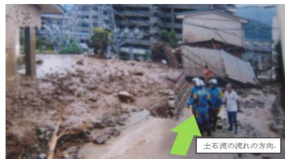
写真-3 地点J付近における家屋の被災状況
