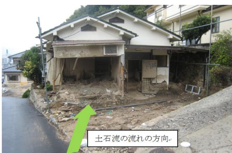
写真-2 地点D付近における家屋の被災状況
