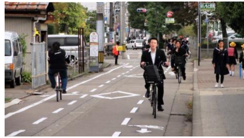
写真-1 金沢中央小学校前で整備された自転車走行指導帯
