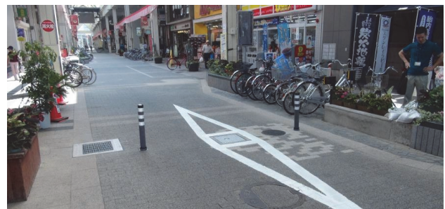
図-10 ライジングボラード下降時の様子
