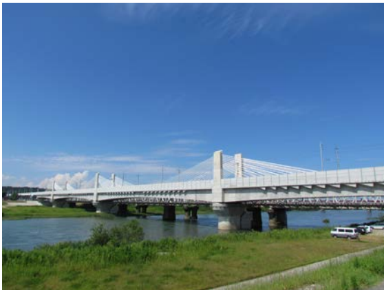
写真-9 神通川橋梁全景
