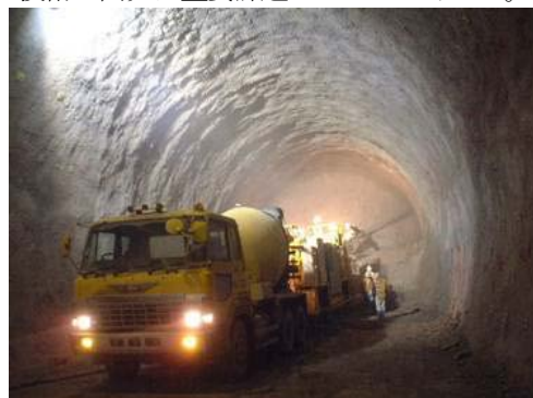
写真-2 初期高強度吹付コンクリート施工状況
