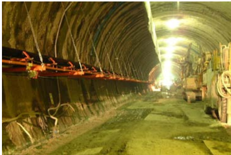
写真3 朝日トンネル西工区
