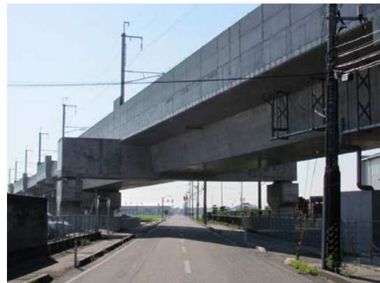
写真-10 馬桁一体型PC橋
