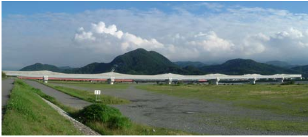
写真-5 姫川橋梁全景
