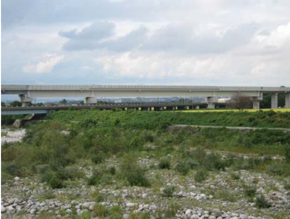
写真-8 浅生架道橋全景
