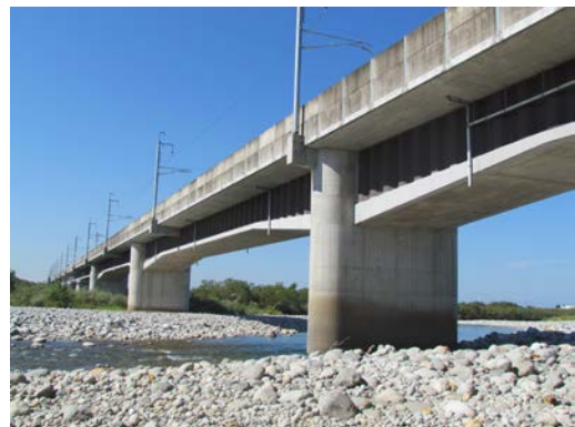
写真-7 黒部川橋梁全景
