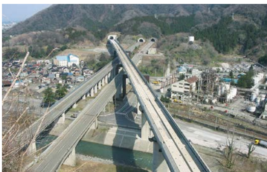
写真-6 北陸道架道橋全景
