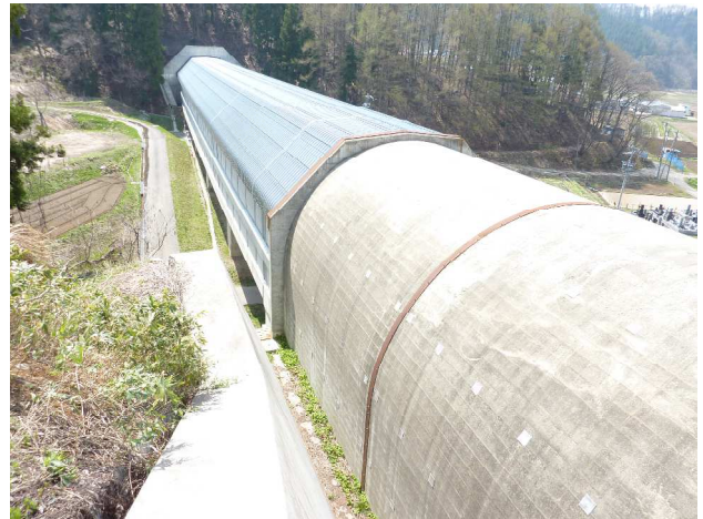
写-5 スノーシェルター
