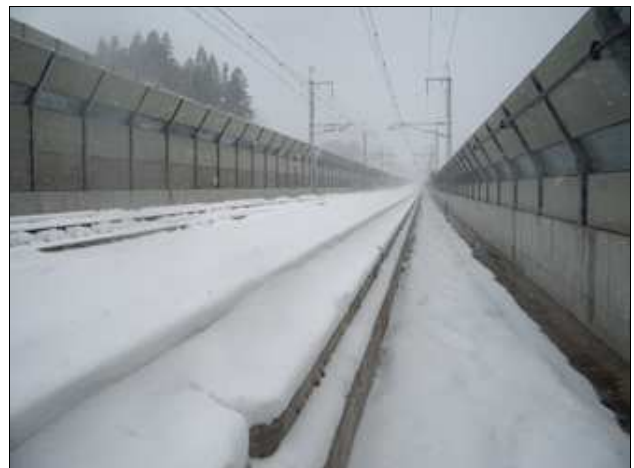
写-6 貯雪状況(東北新幹線より)
