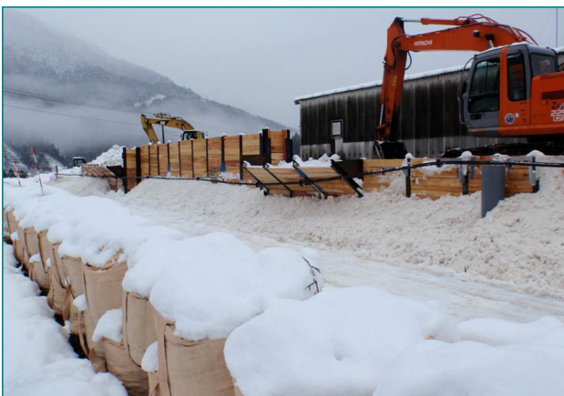
写-2 貯雪機能確認試験状況
