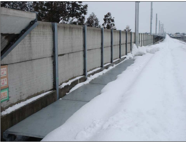
写-7 パネル融雪による消雪状況
