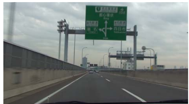
写真-2 図形タイプ標識（600m 手前）
