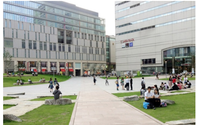
写真-9 新警固公園に新設された中央園路 (写真右側ソラリアプラザの外壁は5章で述べる改修の前)
