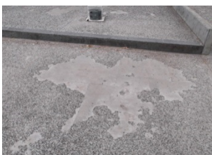
写真-3 舗装の破損状況
