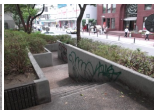
写真-4 壁面の落書き
