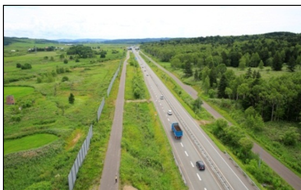
写真-1 国道40号稚内市更喜苦内道路 (平成26年8月撮影)
