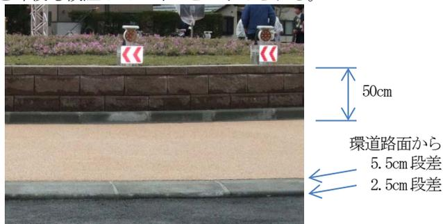
図-12 中央島及びエプロン段差施工写真
