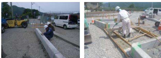
写真-11,12 路面排水構造物や縁石などの小構造物の設置
