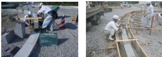
写真-13,14 中央島・エプロンの施工
