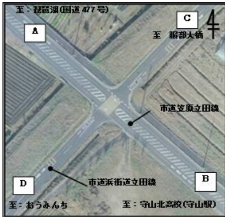
図-2 立田町交差点の改良前の状況
