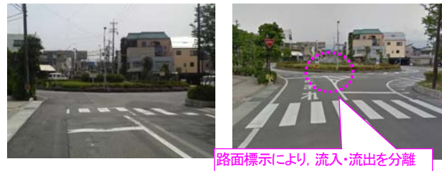
図9 分離島設置の状況
