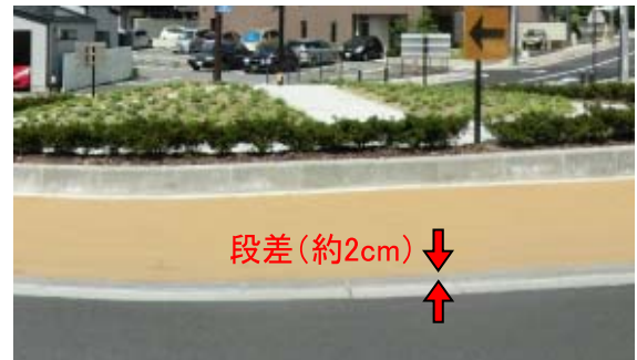
図 16 東和町ラウンドアバウトのエプロン構造
