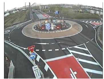
図-5 守山ラウンドアバウト (資料提供：守山市)
