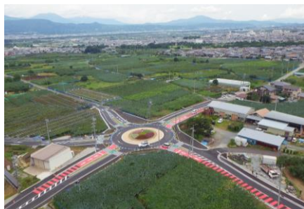
図-6 須坂ラウンドアバウト (資料提供：須坂市)
