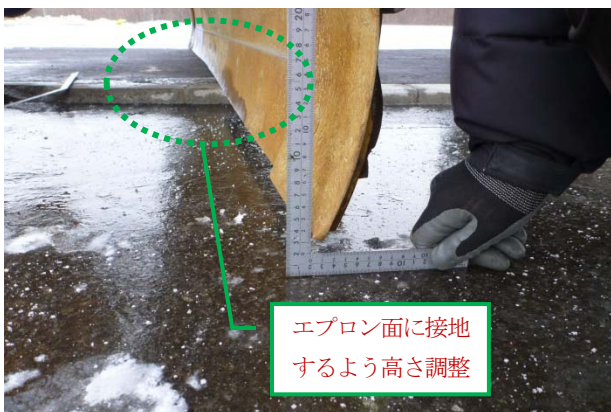
図-10 ブレードの接地状況（モータグレーダ）
