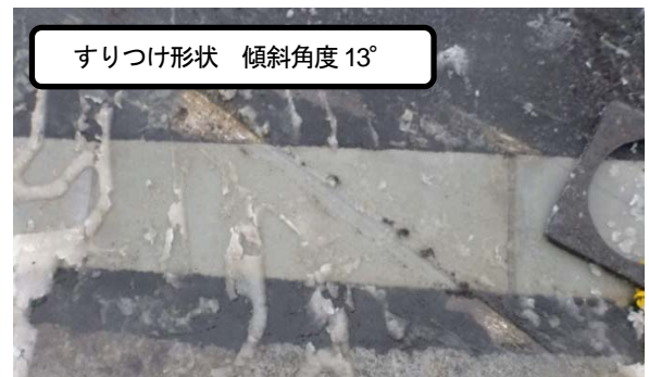
図-15 縁石の損傷状況（ホイールローダ）
