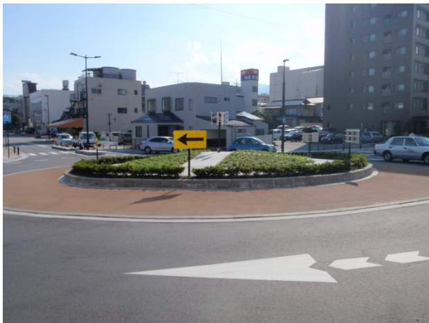
写真-1 ラウンドアバウト（長野県飯田市）
