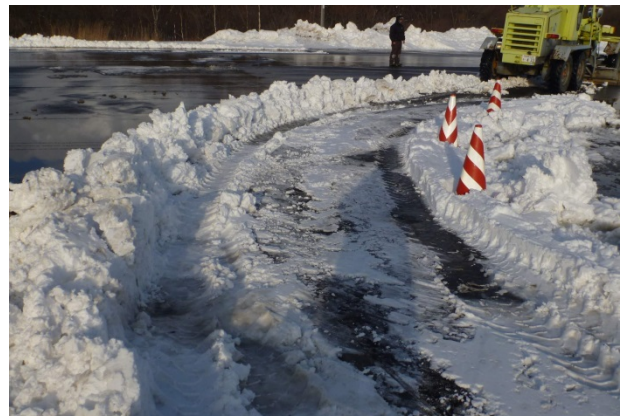
図-11 残雪の発生状況（モータグレーダ）
