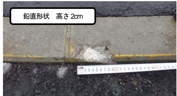
鉛直形状 高さ 5cm（鉛直部 2cm+傾斜面）
