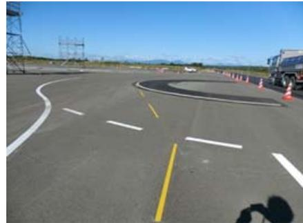
写真-2 誘導線（写真中の黄色線）※流入部から撮影
