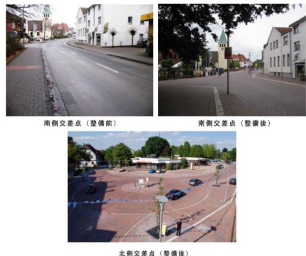
図2 ボームテにおける整備前
