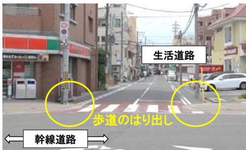
図-1 A交差点の概観(交差点狭さく)
