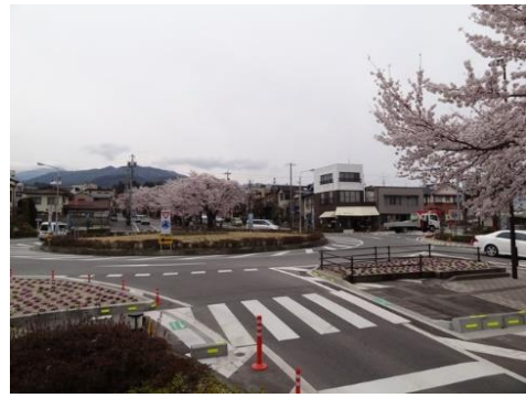
図1 吾妻町のラウンドアバウト(飯田市HPより引用)
