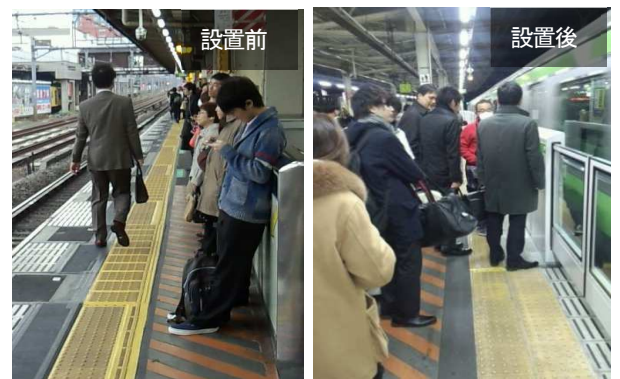
図-19 狭隘箇所における乗車待ち（腰高式）
