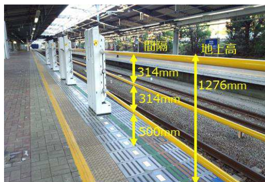
図-15 バー式ホームドア概要
