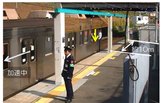
図-11 ロープ式ホームドア閉扉開始時
