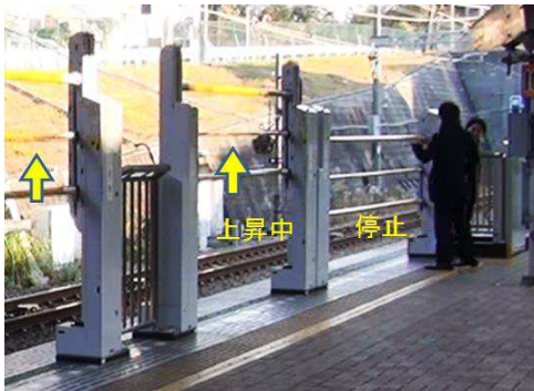
図-12 近接センサ支障による開扉停止の様子
