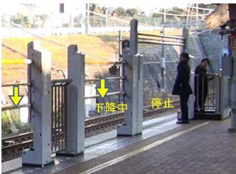
図-13 近接センサ支障による閉扉停止の様子
