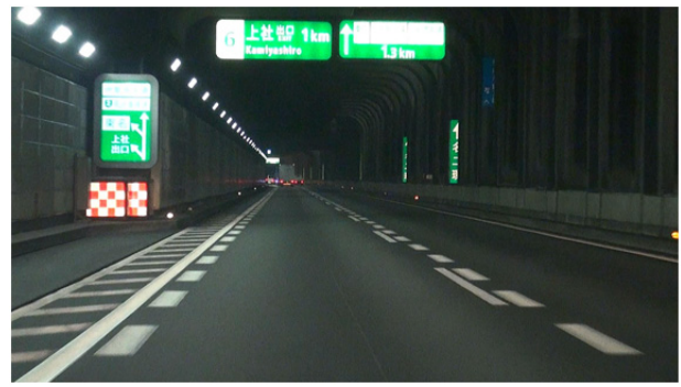
図-2 掘割区間 (2.9kp 付近)
