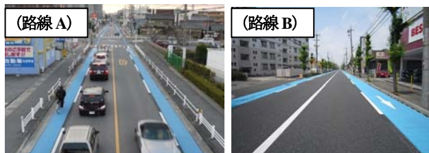
写真-1 調査対象路線の状況
