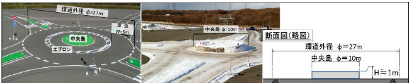
図-1 模擬ラウンドアバウトの設置状況
