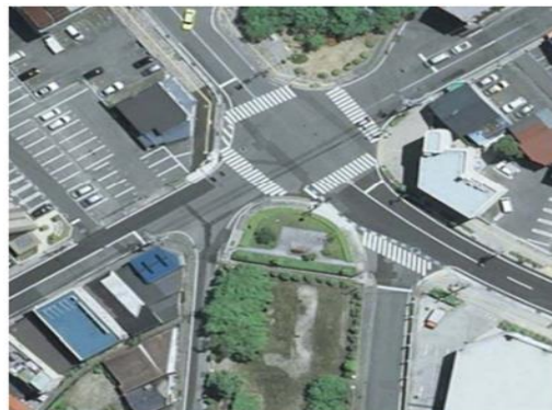
図-1 施工前の信号交差点
