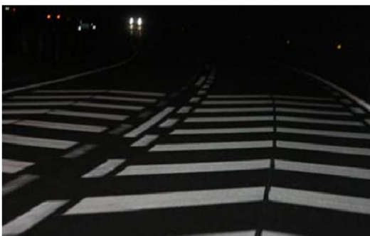
写真-12 AWTを用いたシェブロン路面標示夜間視認状況
