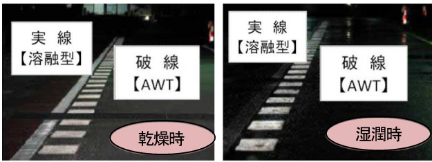
写真-2 乾燥・湿潤時の溶融型と全天候型の視認性状況
