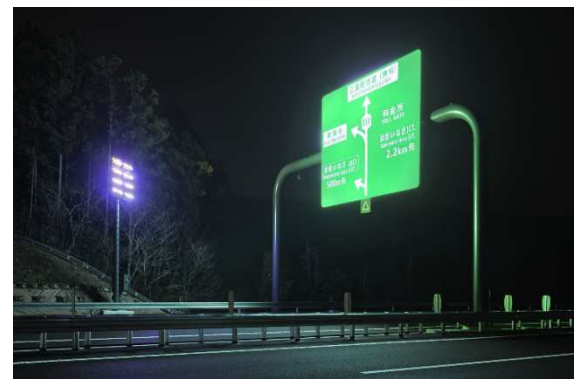
写真-10 大型図形紫外線発光標識 (夜間発光) 写真 (上:新清水JCT付近 下:引佐JCT付近)
