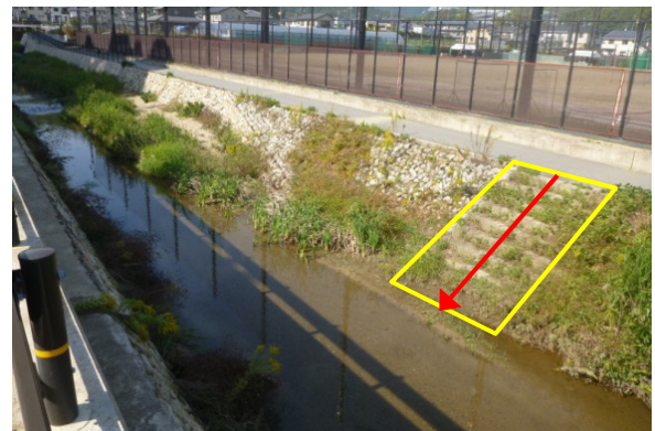
図-6 X川のB区間に整備されたアプローチ（階段）
