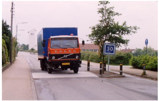
制限速度は 30km/h、対面通行の道路で、局部的に車線幅を 1 車線に狭め、路面を盛り上げている。ただし、側方には、自転車の通行帯を確保。数十mおきにこうした装置を配置しているので、速度抑制効果は大きい。
