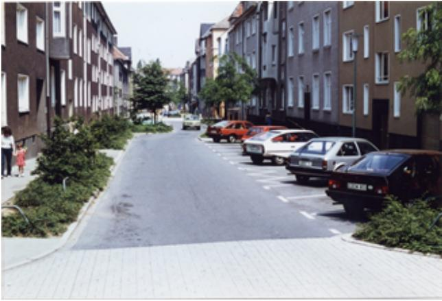
車道を狭め、駐車スペースを道路の左右に交互に設けている。これによって歩車道は区分されたままであるが、車道の中心線を左右にずらせて、車の走行速度を抑制している。手前の交差点部分は、タイルで舗装し路面を盛り上げて走行車両の注意を喚起している。
