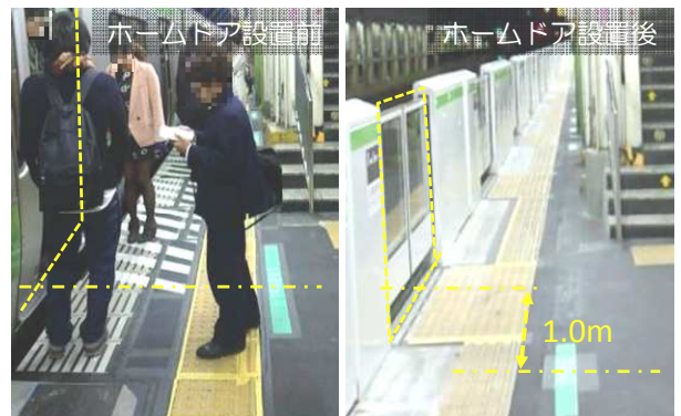
図-10 ホームドア設置による整列位置の変化（腰高式）
