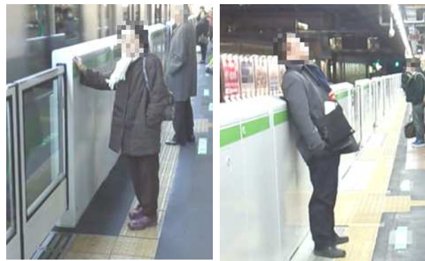
図-8 ホームドアへの接触、寄りかかり（腰高式）
