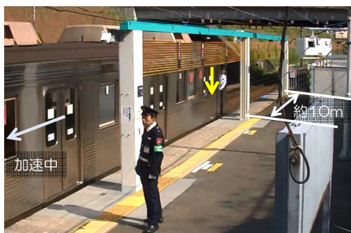
図-18 ロープ式ホームドア閉扉開始時
