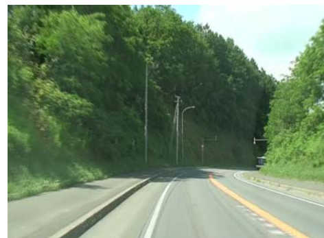
写真-14 迫ってくるカーブと切土法面
