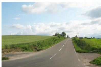
写真-5 自治体による郊外観光地における電線地中化事例（美瑛町提供）
