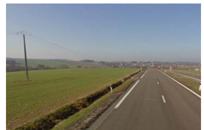
写真-6 フランスにおける民地への大幅なセットバック事例 (画像：https://maps.google.com/maps)
